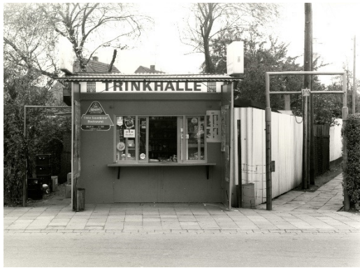
Trinkhalle Düsseldorf Höherweg 300
